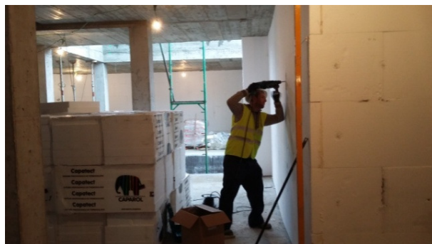
Fotografías nº 4 Instalación de aislamiento : EPS por el interior, EPS continuo por el exterior.
