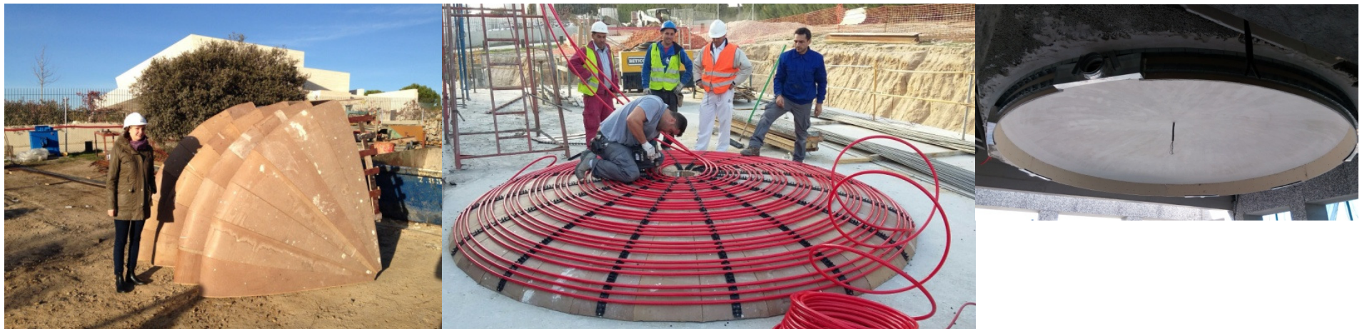
Fotografías nº3 de la fase de ejecución y final de la instalación de techo refrescante durante la fase de ejecución de estructura: Encofrado, colocación de tubo, y cúpula resultado.
