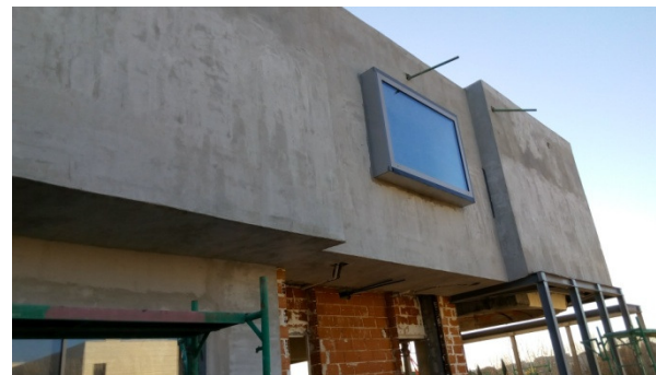
Fotografías nº 4 Instalación de aislamiento : EPS por el interior, EPS continuo por el exterior.
