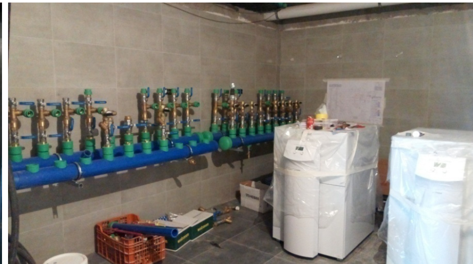
Fotografías nº8 y nº 9 del cuarto de instalaciones de la vivienda objeto. Depósitos y mochilas de ACS, Colectores y bombas de geotermia. Fuente: Elaboración propia.
