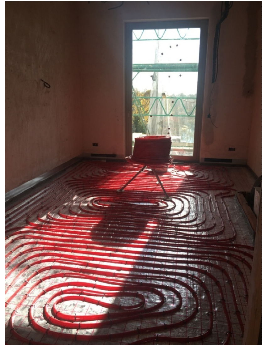
Fotografía nº 10 Suelo radiante del despacho de planta primera de la vivienda objeto. Fuente: Elaboración propia.
