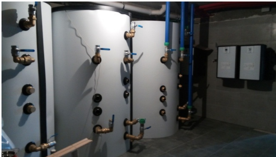
Fotografías nº8 y nº 9 del cuarto de instalaciones de la vivienda objeto. Depósitos y mochilas de ACS, Colectores y bombas de geotermia. Fuente: Elaboración propia.
