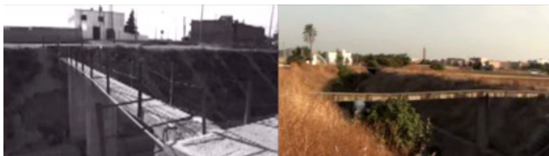
Figura 1. Puente popularmente conocido como “el puente chico”, en el barrio de Palmete, Sevilla.
