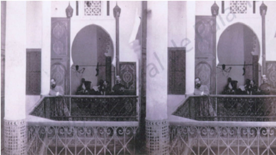
F.10. Interior de un edificio en Tetuán. Vista estereoscópica de Facio (AGP).
